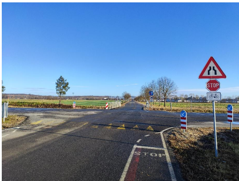
14. 14: Rendeszt kiegyenlített kereszteződés a forgalomcsillapítás, valamint a kerékpárosok és gyalogosok biztonságának növelése érdekében az LC-430031 Turnišče-Dobronak kereszteződésben a JP-707651 Radamos kanal-kavicsbánya önkormányzati közúttal
