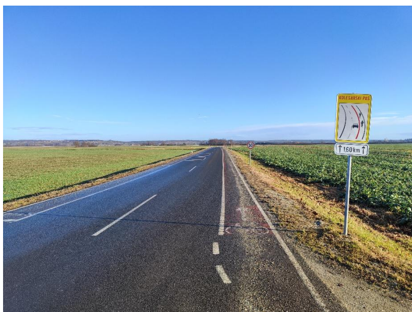
13. 13: Rendezett kétirányú kerékpársáv az LC-430031 Turnišče-Dobronak önkormányzati helyi úton (településen kívül)
